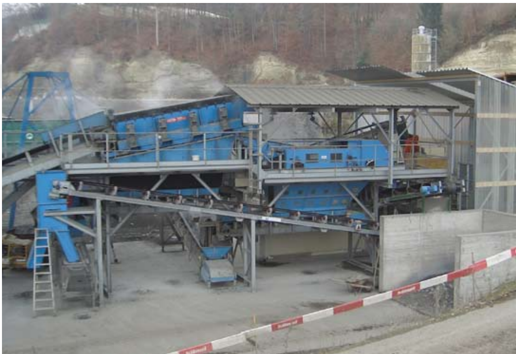
Schlackenaufbereitungsanlage der Deponie Teufstal (BE): Obligatorische mechanische Metallentfrachtung ist absehbar
