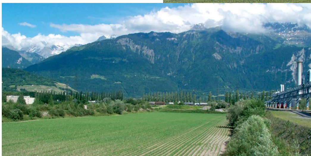
Bilder oben und links: Standort für die geplante RESH-Verwertungsanlage bei der Cimo SA in Monthey
